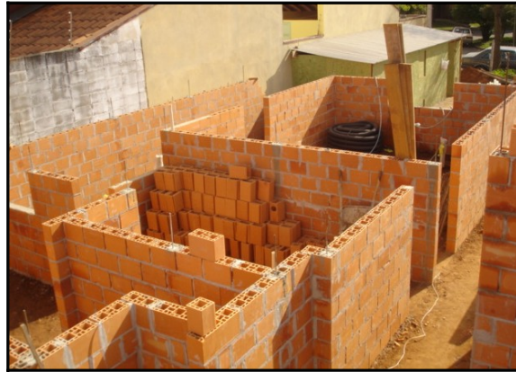
Edificação em construção.
