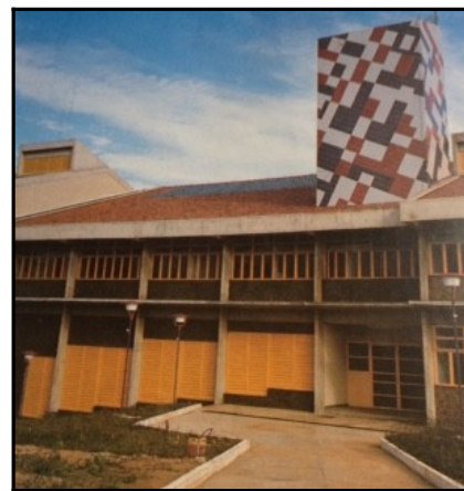
Figura 4 – Fachada Sul – PROJETO, São Paulo, set. 1993.
