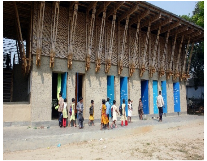
Parte da fachada principal da Escola Meti. Disponível em: < http://www.arquitetandonanet.blogspot.com >. Acesso em: 16 fev. 2022.
