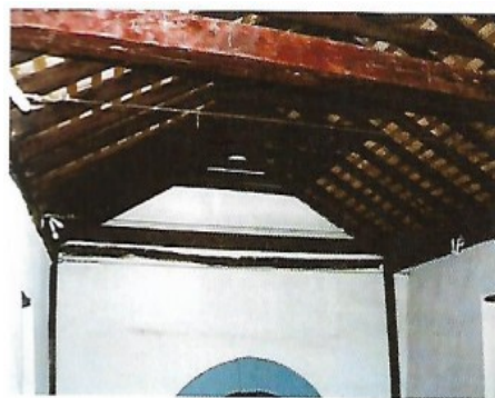
Estrutura do telhado. MOURA, Nádía Mendes de. Arquitetura em pedra-sabão: Análise da Igreja de Santa Bárbara . Goiânia: Ed. da UCG, 2003.
